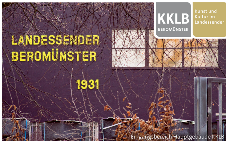
Eingangsbereich Hauptgebäude KKL
