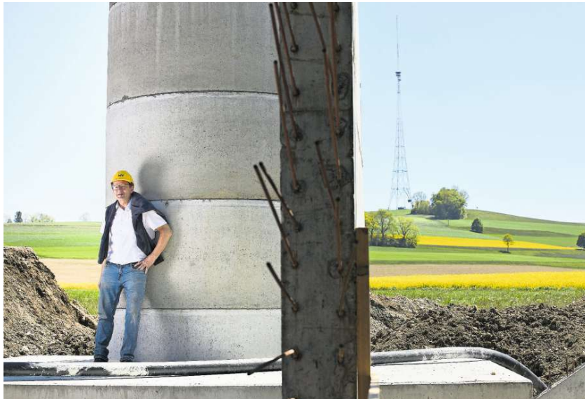
Der Künstler Wetz vor seiner KKLB-Metrostation. Viel roher Beton steht bereits.
